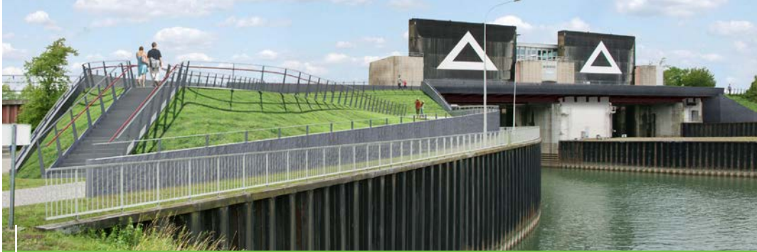
Brücke über die Schleusen
